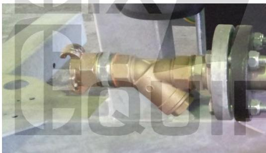
Figure 13 : filtre à eau 1" Y (400 microns)
