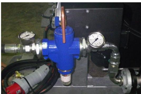
Figure 14 : filtre à eau 2" à chasse (300 microns)
